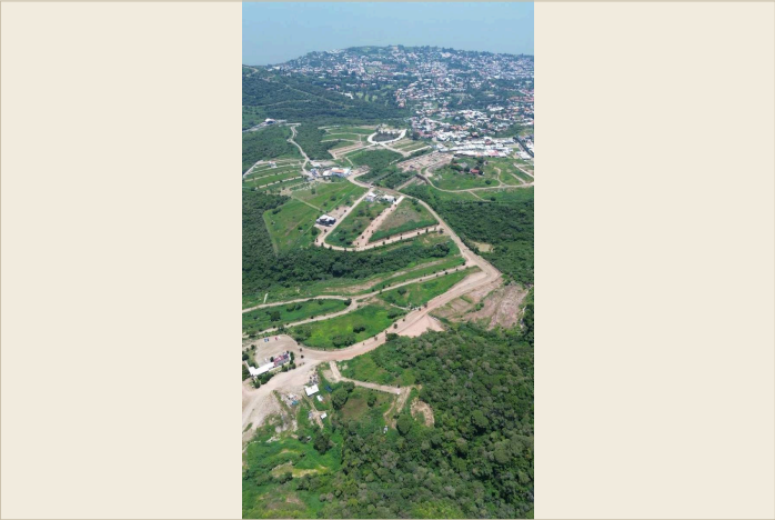
Foto aérea del terreno
